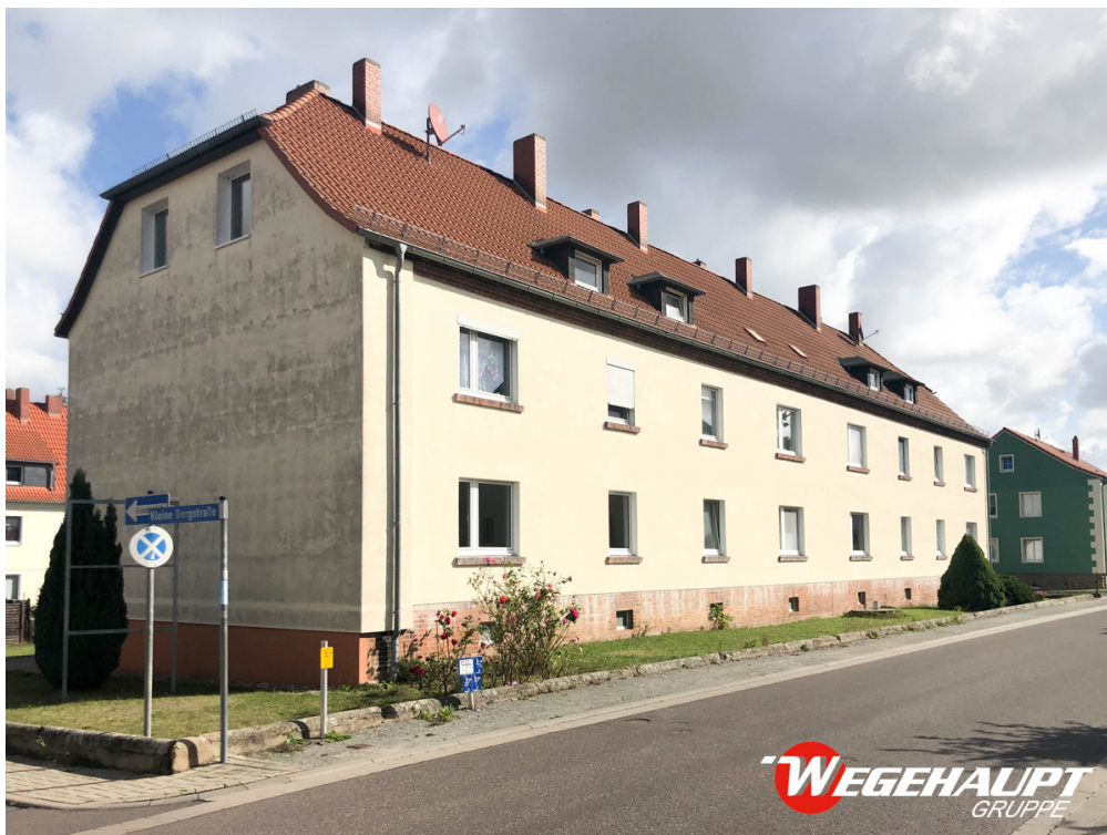
Ansicht Bergstraße 11 und 13
