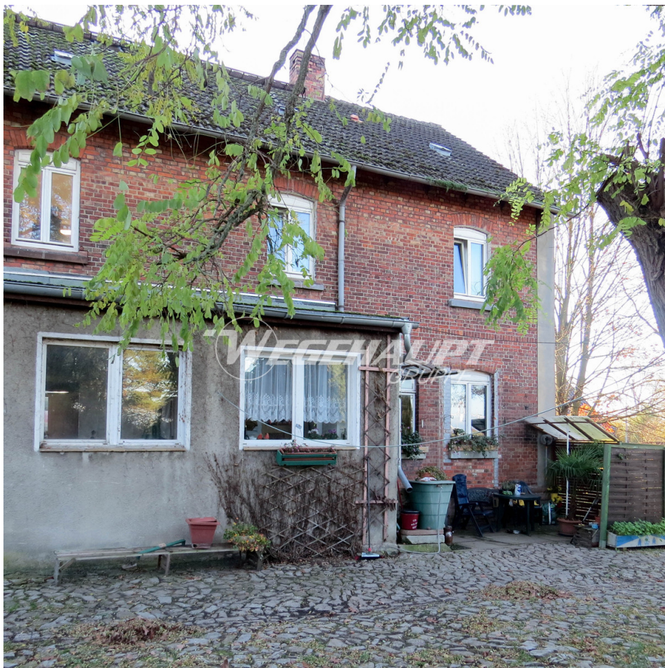
Hauptstraße 33 - Außenansicht Hof
