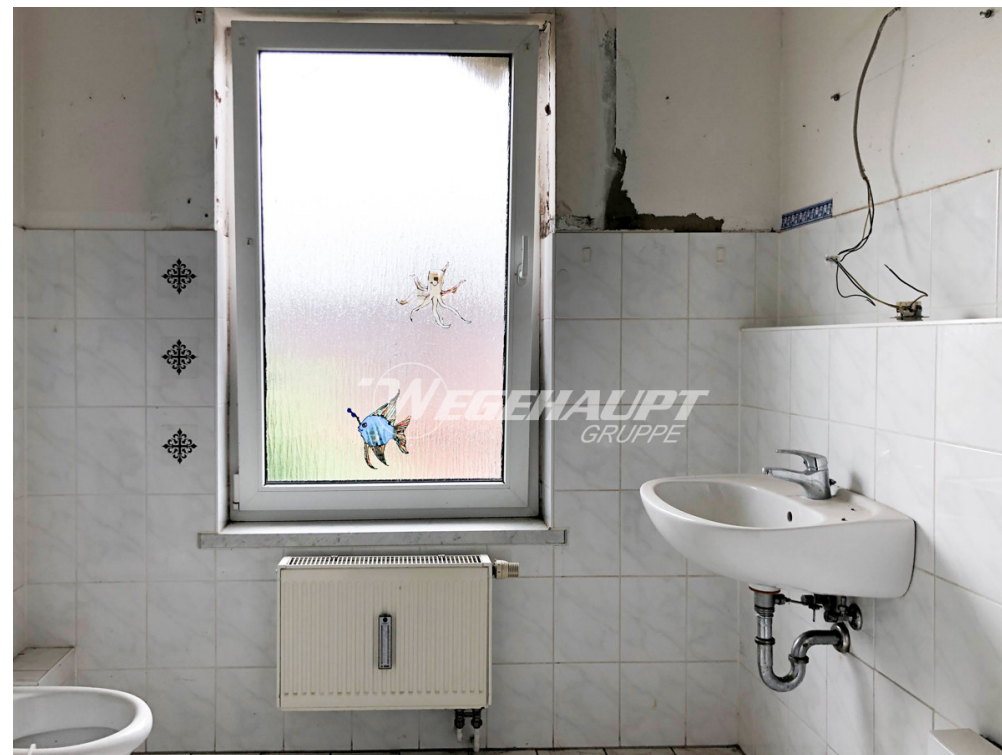
Hauptstraße 9-12 Obergeschoss Bad
