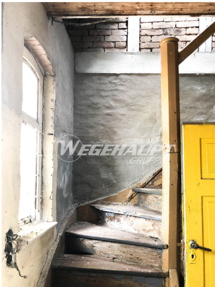
Hauptstraße 7 - EG Treppe
