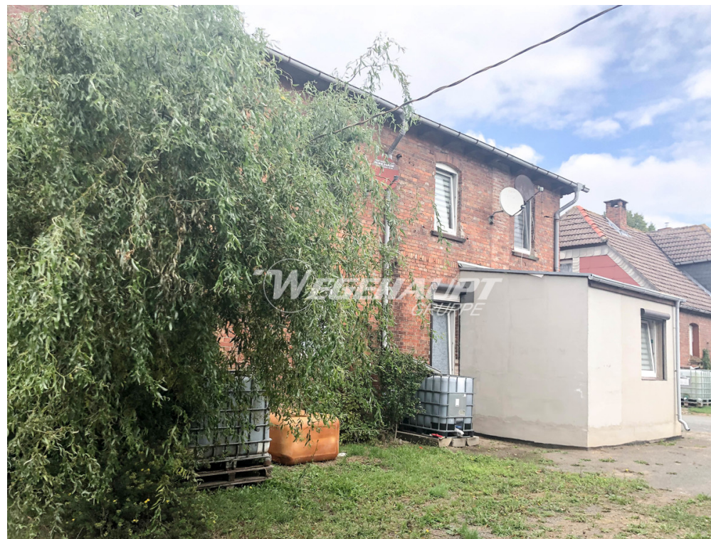
Hauptstraße 9-12 Ansicht Hof
