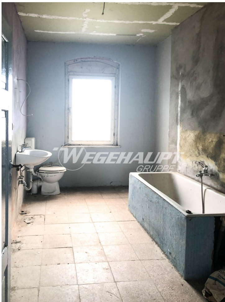
Hauptstraße 7 - EG Bad
