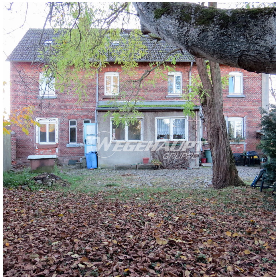
Hauptstraße 33 - Außenansicht Hof
